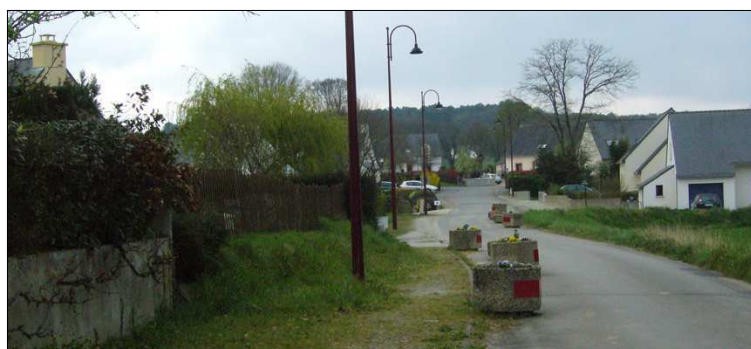
Rue de l'Espérance : les courbes de la voie, l'absence de trottoirs, de limites franches entre espace routier et piéton, incite au ralentissement automobile. Une ambiance de ruralité se dégage de la rue.
