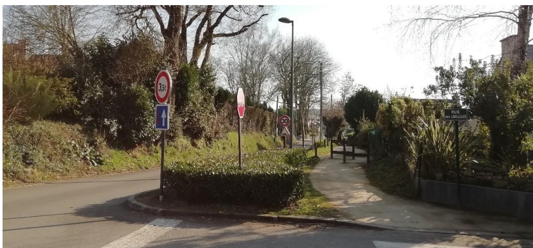
Figure 6 : Cheminement doux dans le bourg de Locqueltas - Gama Environnement
