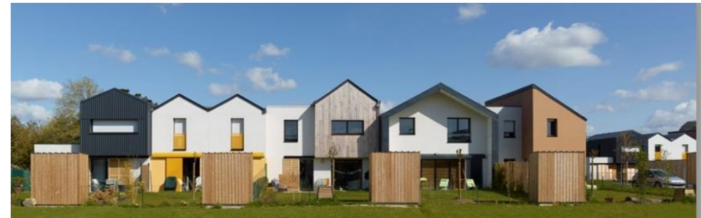
Opération groupée « Vert Buisson » à Bruz (35)
