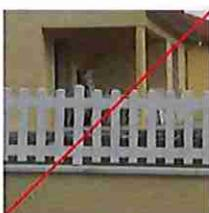
Muret maçonné réhaussé de bardage PVC
